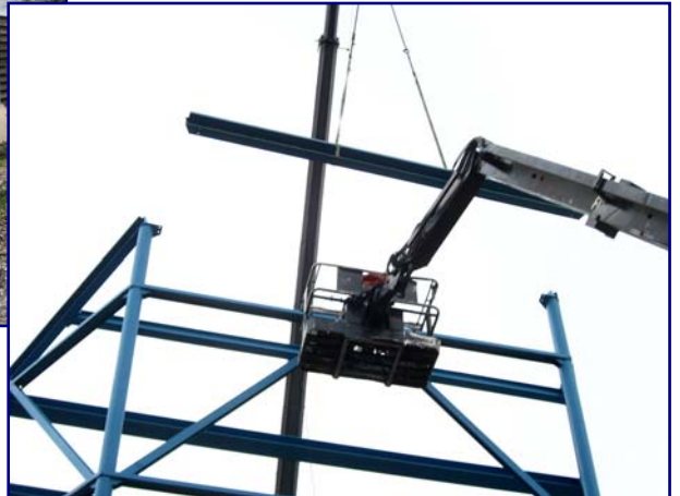
Am 30. Oktober kann der letzte Stahlträger zum Dach eingesetzt werden (oben)
